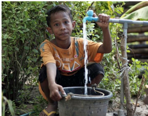
納格克各地的村莊合共安裝了64個新水箱。
